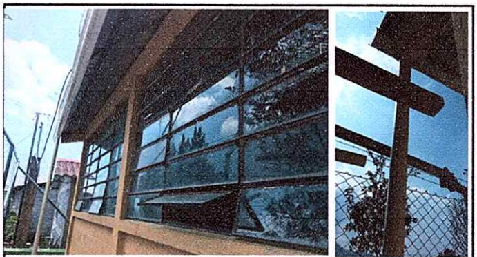
Foto 4: MODULO 1 Sustitución de canal de pvc por metal, sustitución de bajada de agua pluvial de PVC
