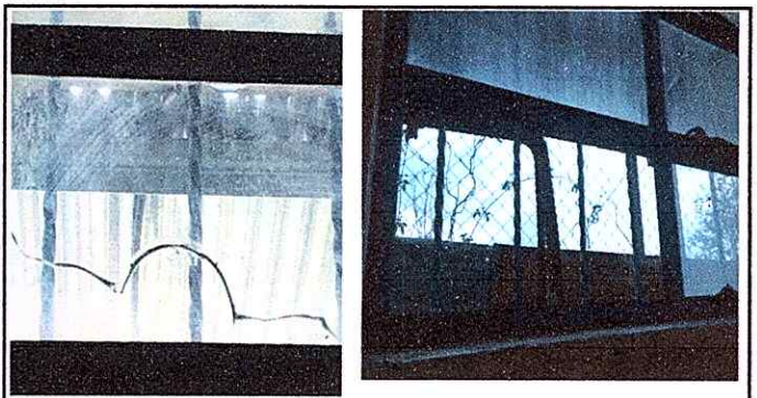
Foto 10: MODULO 2 Sustitución de vidrios
