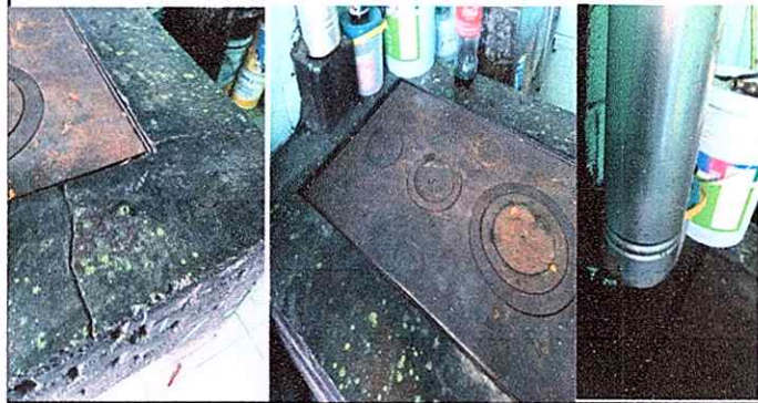
Foto 1: MODULO 1 Sustitución de estufa rural (completa) incluye chimenea y plancha de metal
