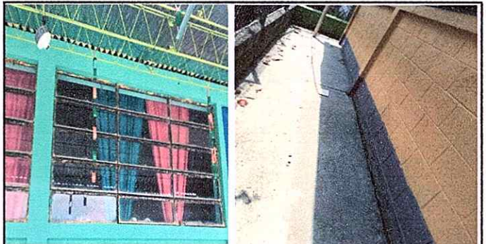
Foto 6: MODULO 1 Fabricación e instalación de ventana-balcon de metal, Pintura en muros exteriores e interiores
