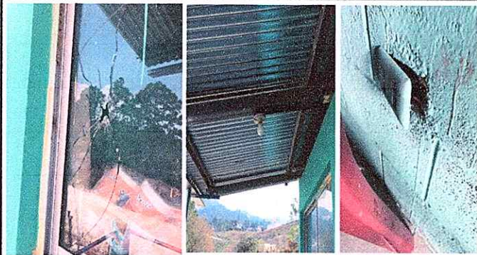
Foto7: MODULO 2 Sustitución de ventanas de aluminio por ventanas PVC, sustitución de lamparas a tipo LED y sustitución de tomacorrientes dobles
