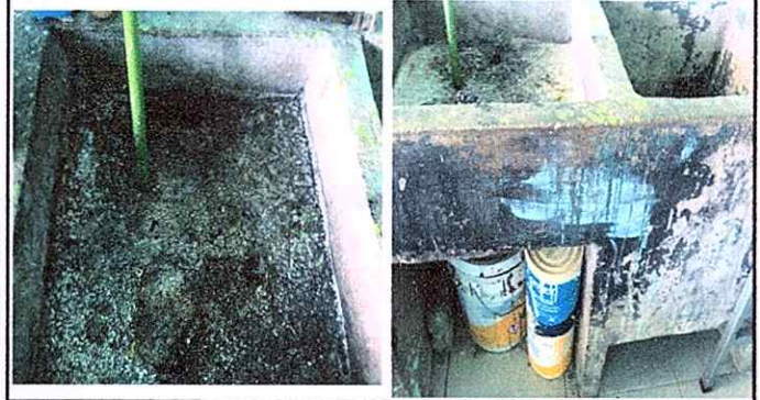
Foto 2: MODULO 1 Sustitución de pila de cemento de dos lavadero por una formal Y Aplicación de azulejo en pila de concreto
