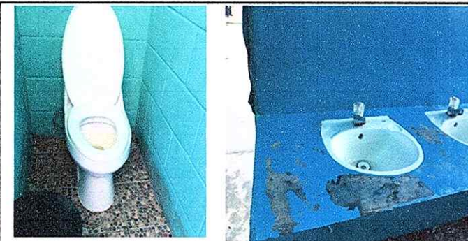
Foto 11: MODULO 3. Aplicacion de azulejo en paredes de sanitarios y lavamanos
