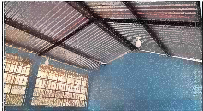
Foto 4: instalacion de unidad de luz
