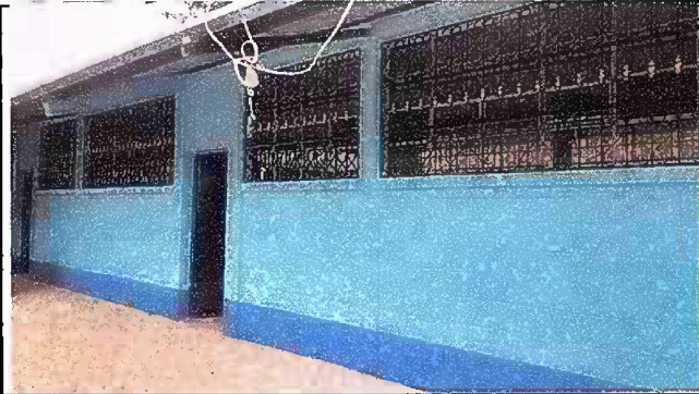
Foto1: suministro e instalacion de balcon de metal
