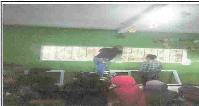
Foto 3: MODULO 2 COLOCACIÓN DE VENTANAS DE METAL POR PVC MAS VIDRIO
