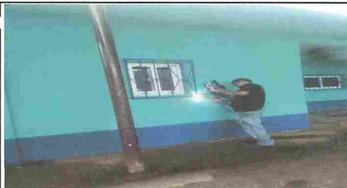
Foto 4: MODULO 2 MANTENIMIENTO A BALCONES DE METAL
