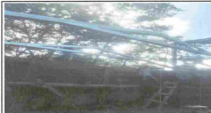
Foto 9: REPARANDO TECHO EN BODEGA
