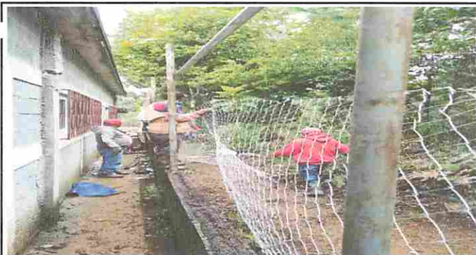
Foto 10: REPARANDO MURO PERIMETRAL
