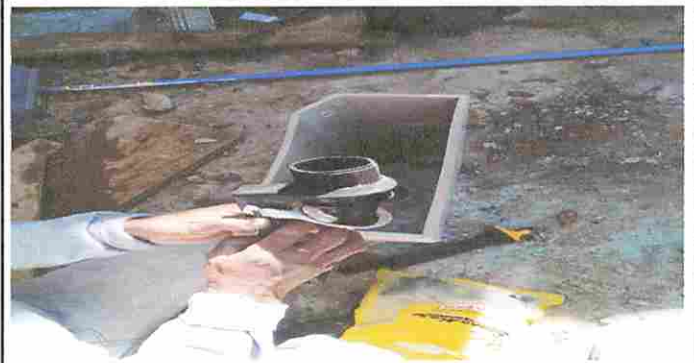
Foto 8 SUSTITUYENDO ACCESORIOS EN BAÑOS
