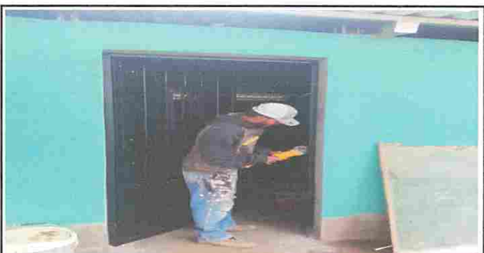
Foto 12: COLOCACION DE PUERTA DE METAL EN BODEGA
