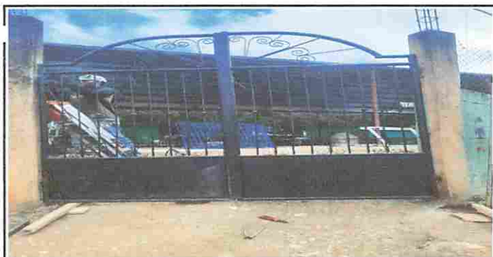
Foto 11: COLOCACIÓN DE PORTON DE METAL
