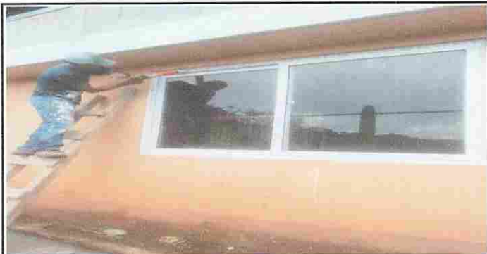
Foto1: MODULO 1 COLOCACIÓN DE VENTANAS DE PVC
