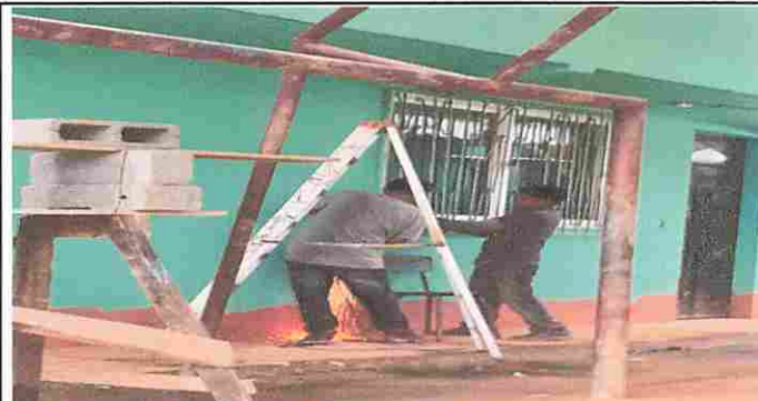
Foto 2: MODULO 1 INSTALACIÓN DE BALCONES DE HIERRO EN VENTANAS
