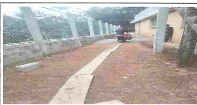
Foto 6: COLOCACIÓN DE PLANCHAS DE CONCRETO EN PATIO
