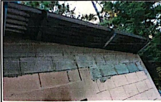
Foto 8: modulo 3 levantamiento de mojinetes
