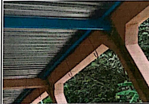
Foto 2: Modulo 1 mantenimiento de estructura de soporte
