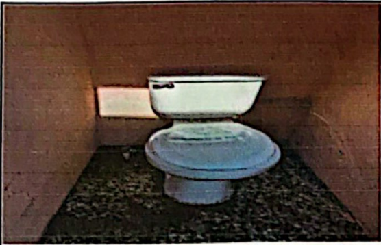
Foto 7: Modulo 2 sustitucion de inodoros
