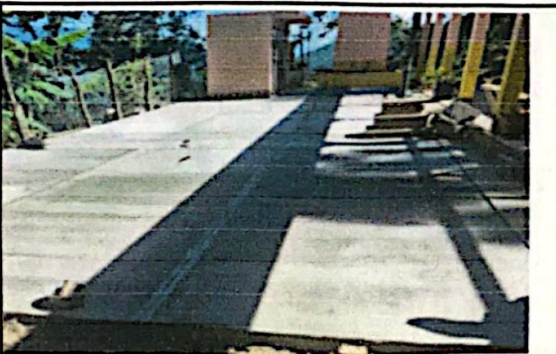
Foto 11. modulo 3 patio reparacion de plancha de concreto de patio
