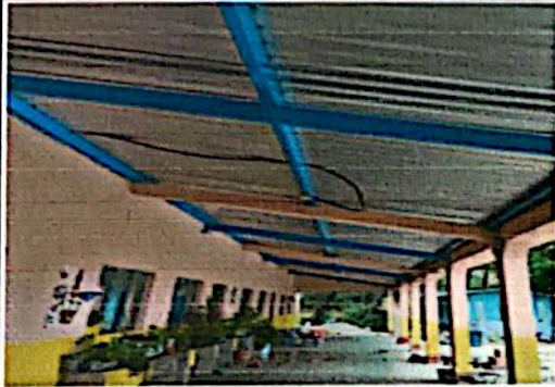
Foto 1: modulo 1 Sustitucion de lamina por lamina troquelada aluzinc cal. 26,
