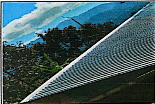
Foto 3: modulo 1 sustitucion de capote para capote para lamina troquelada aluzinc cal. 26,
