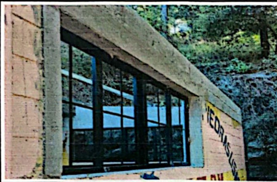
Foto 9: modulo 3 Levantamiento de ventanas
