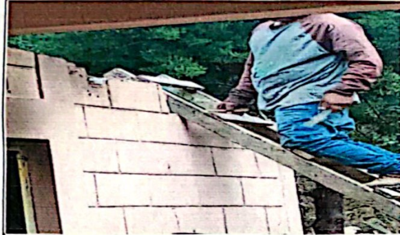
Foto 8: modulo 3 levantamiento de mojinetes
