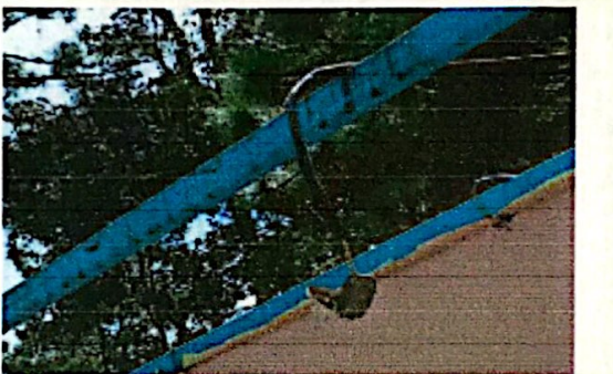
Foto 4: modulo 1 Sustitucion de elemento de fijación (tornillos)
