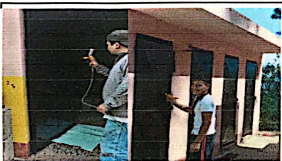
Foto 5: modulo 2 mantenimiento de puerta (lijado cepillado, sustitucion y aplicado de pintura)
