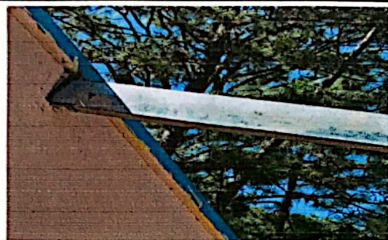
Foto 2: Modulo 1 mantenimiento de estructura de soporte
