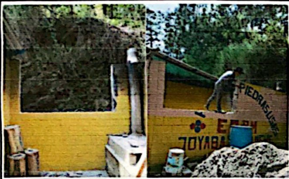
Foto 9: modulo 3 Levantamiento de ventanas
