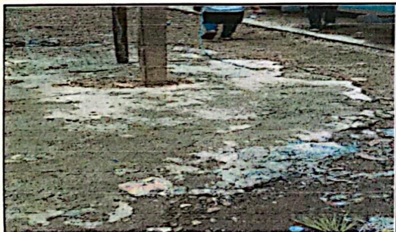
Foto 11. modulo 3 patio reparacion de plancha de concreto de patio
