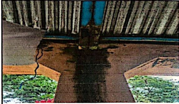
Foto 2: Modulo 1 mantenimiento de estructura de soporte
