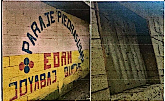
Foto 9: modulo 3 Levantamiento de ventanas
