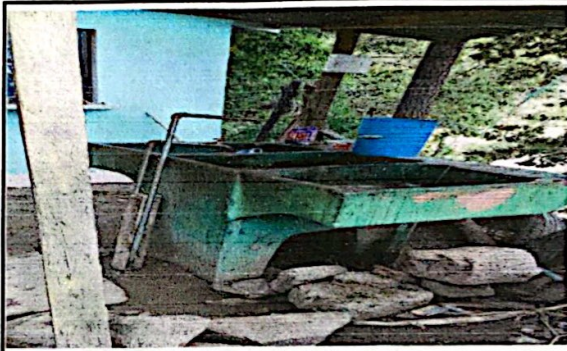
Foto 10: modulo 3 sustitucion de pila de concreto INSITU (2x2)
