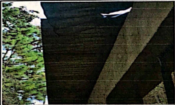
Foto 1: modulo 1 Sustitucion de lamina por lamina troquelada aluzinc cal. 26,
