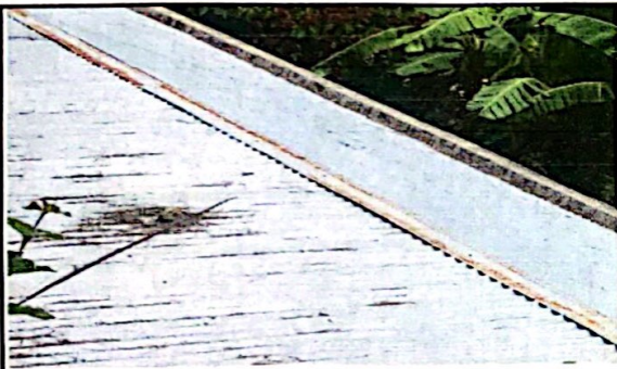
Foto 3: modulo 1 sustitucion de capote para capote para lamina troquelada aluzinc cal. 26,
