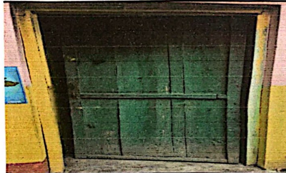
Foto 6 modulo 2 sustitucion de puerta de metal
