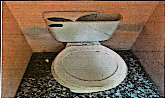
Foto7: Modulo 2 sustitucion de inodoros
