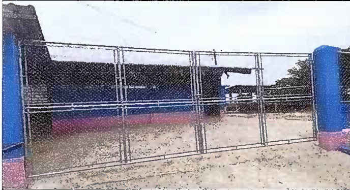
Foto 3: Porton: Mantenimiento a porton, pintura y sustitucion de riel
