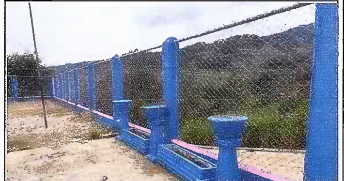
Foto 4: Muro perimetral: Repello en muro
