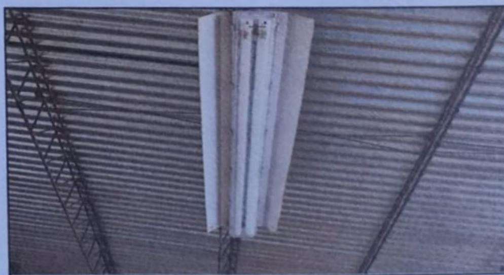
Foto 6: Modulo 1 Sustitucion de lampra tipo led.
