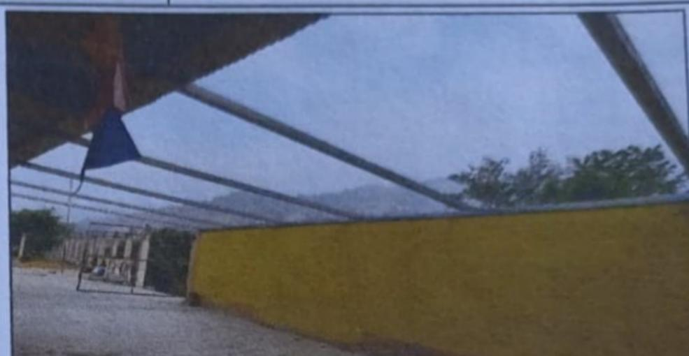
Foto 2: Modulo 1: Sustitución de lamina por lamina troquelada aluzinc cal. 26 y estructura de soporte
