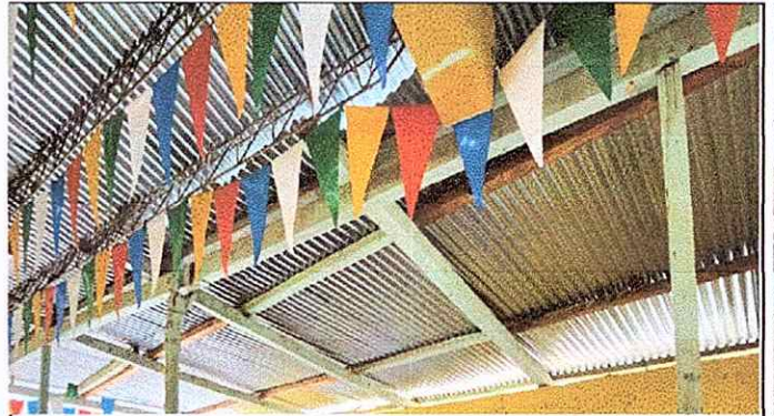
Foto 2:Modulo 1: Sustitucion de lamina por lamina troquelada aluzinc cal. 26 y estructura de soporte
