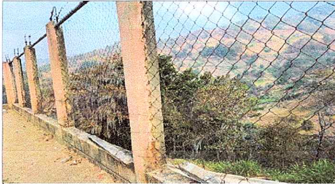
Foto1: Muro perimetral : Reparación de muro perimetral, solera tubo hg leg.
