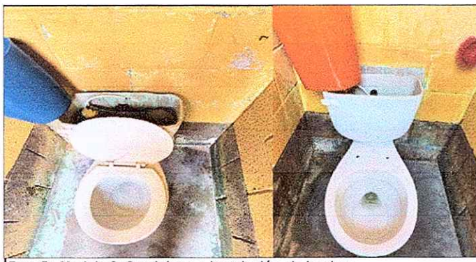
Foto 5: Modulo 2: Suministro e instalación de inodoro
