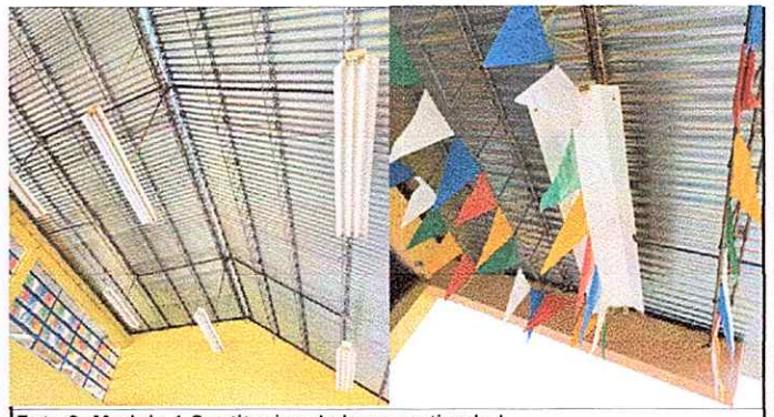
Foto 6: Modulo 1 Sustitucion de lampara tipo led.
