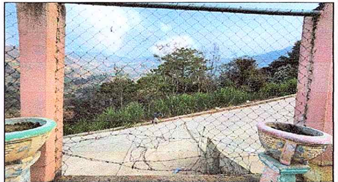
Foto 4: Muro perimetral: Repello en muro
