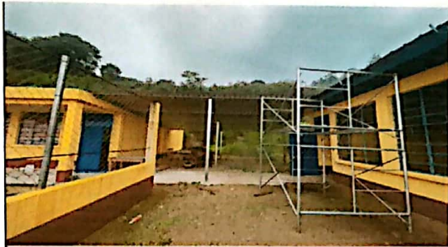
Foto 3: Sustitución de lámina por lámina troquelada y soporte de madera por metal.
