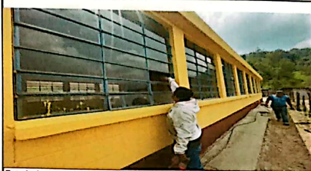
Foto 1: Instalación de vidrios claros de 5 ml.
