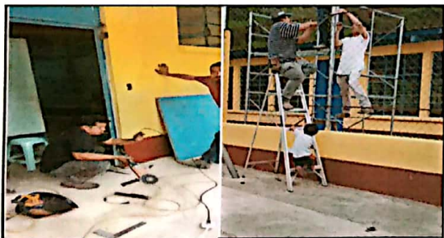
Foto 5: Mantenimiento a puertas de metal, reparación de tubo hg y malla galvanizada.
