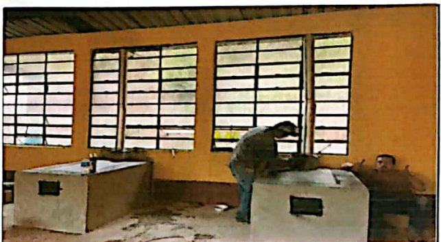
Foto 4: Mantenimiento a estufa rural, chimenea y sustitución de plancha de metal
