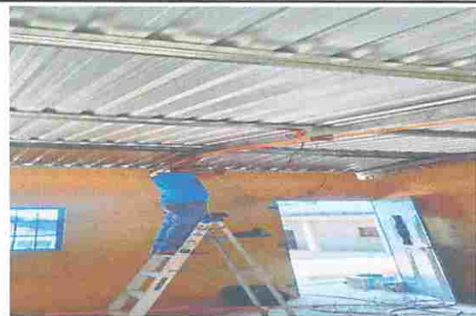
Foto 4: SUSTITUCIÓN DE FOCOS AHORRADORES
