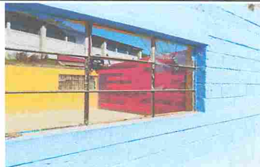
Foto 6: SUSTITUCIÓN DE VALCONES DE METAL.
