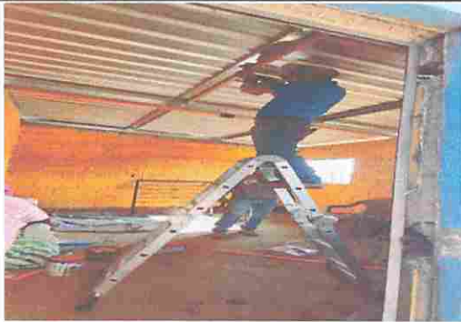
Foto 9: SUSTITUCIÓN DE CABLEADO ELÉCTRICO
