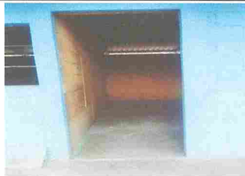
Foto 4: SUSTITUCIÓN DE PUERTAS DE METAL POR PUERTAS DE METAL.
