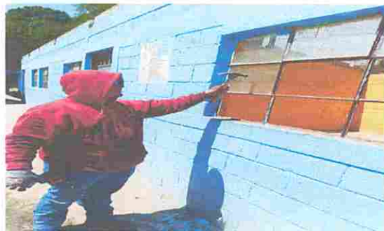
Foto 5: SUSTITUCIÓN DE VIDRIOS, ESTREUCTURA DE METAL Y VALCONES DE VENTANA.
