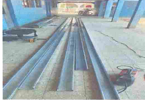
Modulo 8: SUSTITUCIÓN DE CANAL DE METAL
