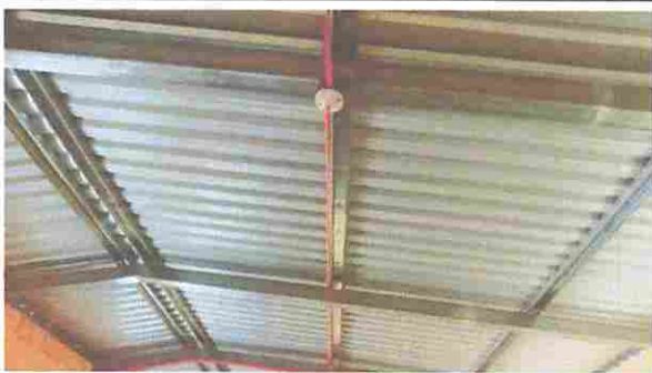
Foto 5: SUSTITUCIÓN DE PLAFONERAS
