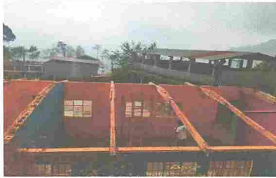
Modulo 1: SUSTITUCIÓN DE LÁMINA, POR LÁMINA TROQUELADA ALUZINC CALIBRO 26
