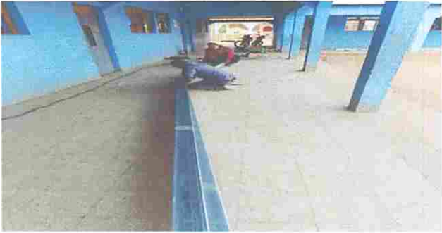
Modulo 7: SUSTITUCIÓN DE CANAL PVC
