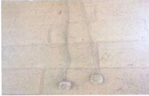
Foto 13: Sustrucción de interruptores dobles.
