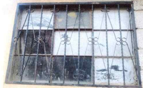
Foto 6: Sustitución de balcones de metal.
