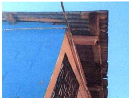
Foto 8: Sustitución de canal de metal.
