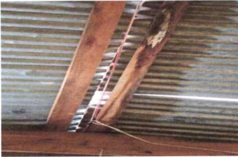
Foto 15: Sustrucción de ducto eléctrico + accesorios.
