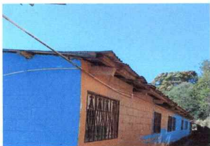
Foto 7: Sustitución de canal de pvc.
