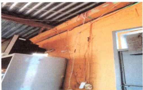
Foto 9: Sustitución de cableado eléctrico.
