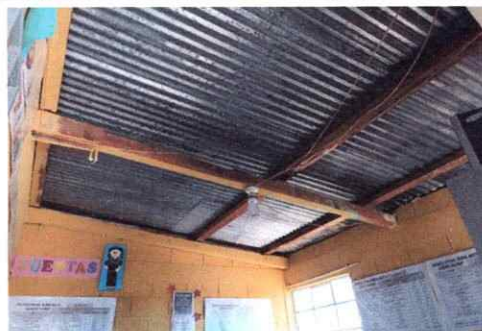
Foto 10: Sustitución de focos ahorradores.
