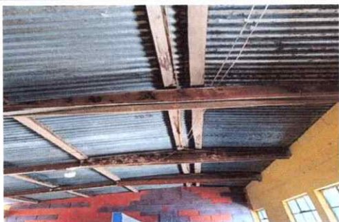
Foto 11: Sustitución de plafoneras
