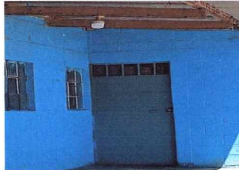
Foto 4: Sustitución de puertas.
