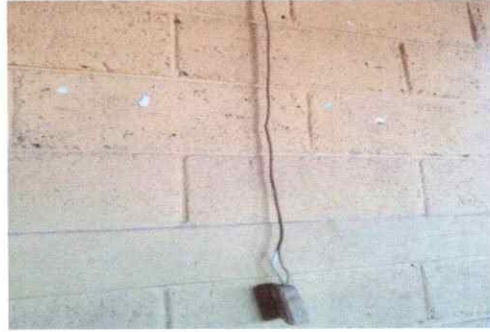
Foto 14: Sustrucción de sustitución de tomacorrientes dobles.
