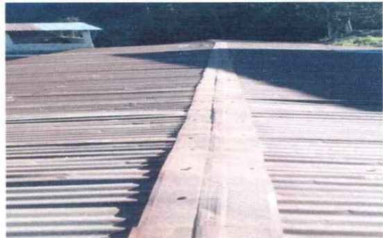
Foto 2: Sustitución de capote de lámina para lámina troquelada.
