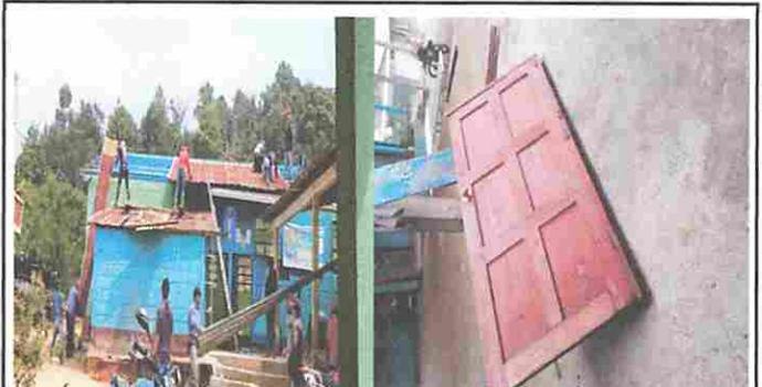
**Foto 2: Modulo 1 Sustitución de lámina, por lámina troquelada aluzinc calibre 26, Sustitución de puerta**
