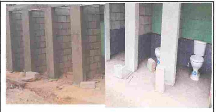
**Foto 6: Sustitución de puertas en servicios sanitarios, sustitución de inodoro**
