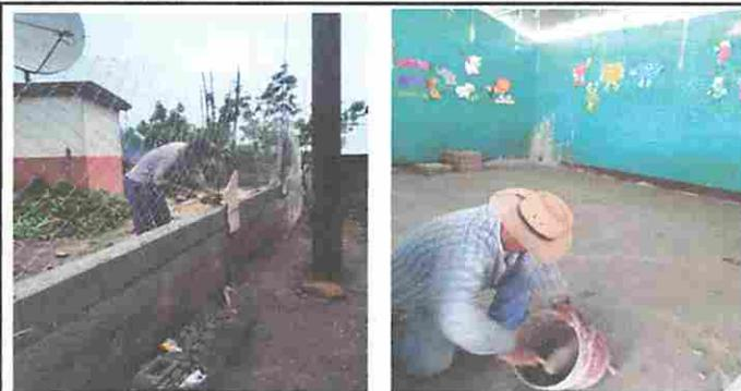
**Foto 5: Modulo 2 Reparación de muro perimetral de block con tubo hg y malla galvanizada, soleras intermedias y columnas, Sustitución de piso de concreto.**
