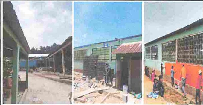
**Foto 1: Modulo 1 Reparación de banquetas de concreto, Pintura de muros exteriores, Sustitución de puerta de servicios sanitarios. Sustitución de estructura de soporte de madera por metal.**
