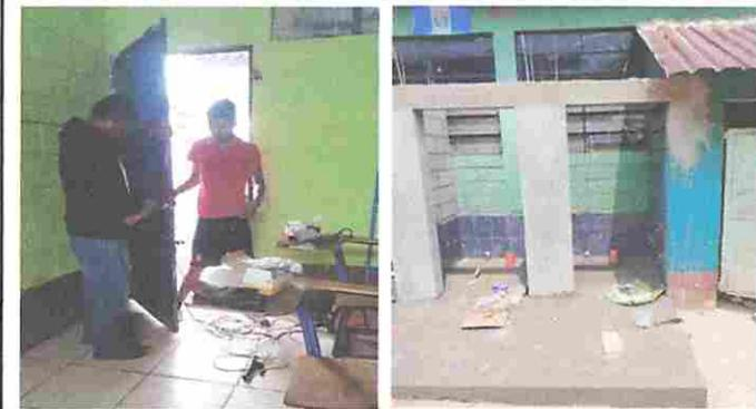
**Foto 3: Modulo 1 Sustitución de chapa, sustitución de inodoro, Instalación de azulejo.**
