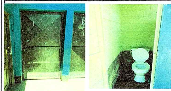
Foto 3: Modulo 1 Sustitución de chapa, sustitución de inodoro, Instalación de azulejo.
