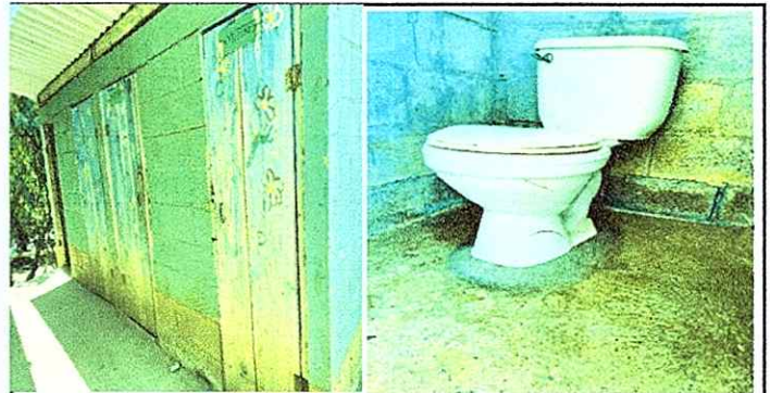
Foto 6: Sustitución de puertas en servicios santarios, sustitución de inodoro
