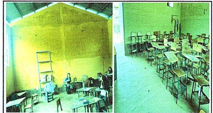
Foto 4: Modulo 1 Repello en muro, Sustitución de piso de concreto,
