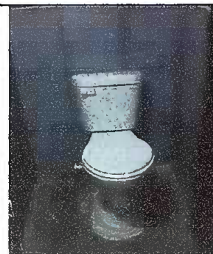
Modulo 1: sustitución de inodoro.
