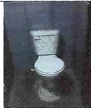
Modulo 1: sustición de inodoro.
