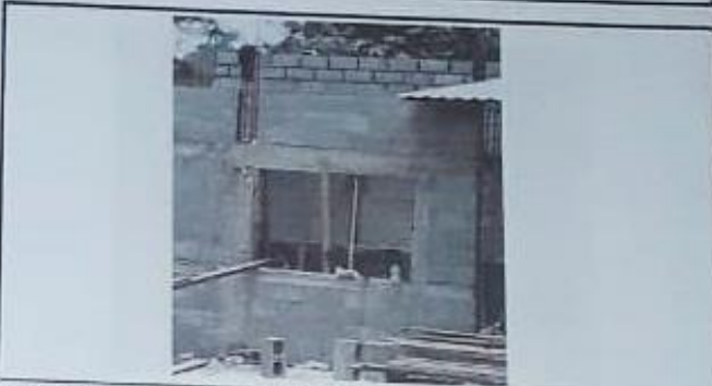
modulo 1: cambio de pared de block.
