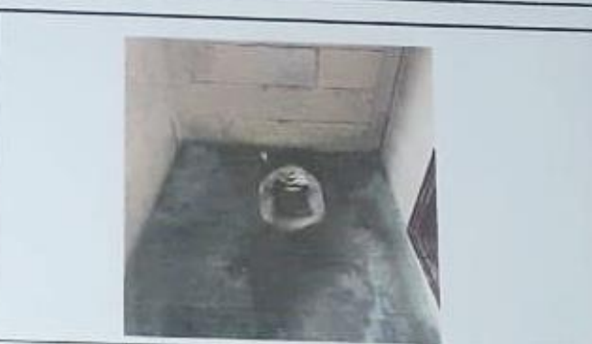
Modulo 1: sustición de inodoro.
