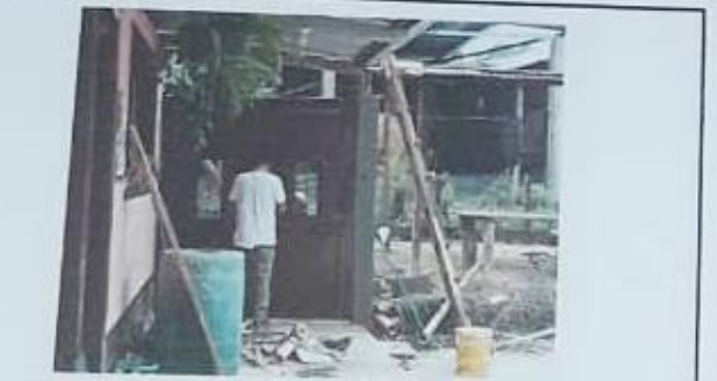
Modulo 1: mantenimiento de porton de metal.
