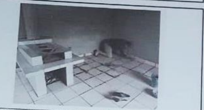
Modulo 1: cambio de torta de cemento por piso cerámico antideslizante.
