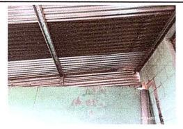
Modulo 1.: sustitución de lámina por lámina troquelada y sustituión de estructura de soporte de metal.
