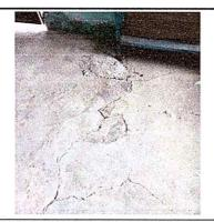
Modulo 1: cambio de torta de cemento por piso cerámico antideslizante.
