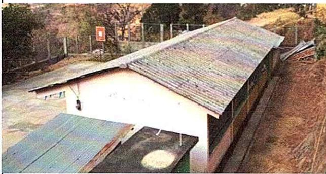
Foto1: Sustitución de lamina, por lamina troquelada aluzinc c- 26
