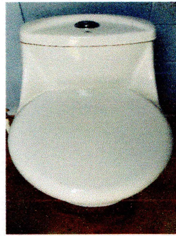
Foto 2: este es la primera instalacion de inodoro y su accesorios.
