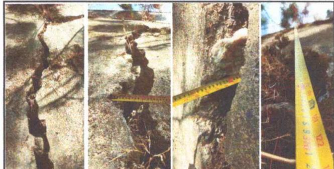
Foto 4: reparación del muro de contención dirección oeste, tiene una grieta de 0.12 centímetros de ancho por 3.10 de alto y 1.10 mts de profundidad.
