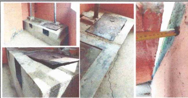
Foto 3: Reparación y ampliación de cocina, reparación completa de estufa rural y reparación de piso de torta de concreto.
