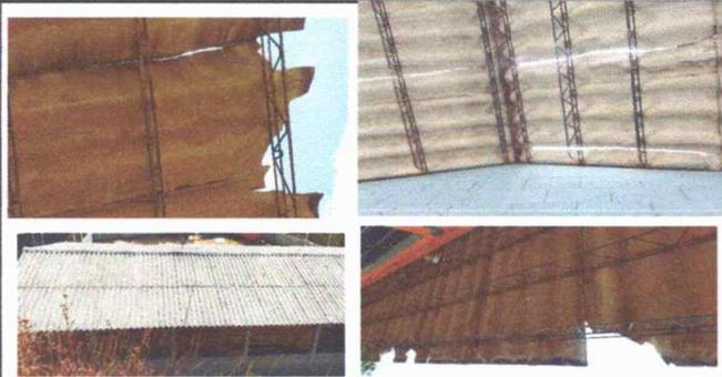
Foto1: sustitución de techo del módulo 1 y capote, el material existente es de duralita, instalado en diciembre del año 2006. lijado y mantenimiento de los yonkis y puertas metálicas y repintado con pintura anticorrosiva.
