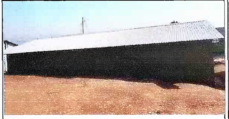
Módulo 2: Sustitución de lámina por lámina troquelada aluzinc cal. 26, Sustitución de capote de lámina para lámina troquelada, Sustitución de elementos de fijación, Sustitución de estructura de soporte de metal, por metal Y
