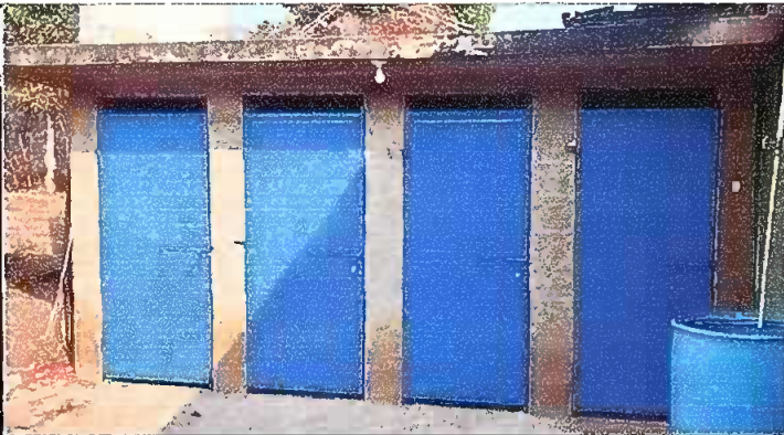
Módulo 3: Sustitución de puerta en servicios sanitarios
