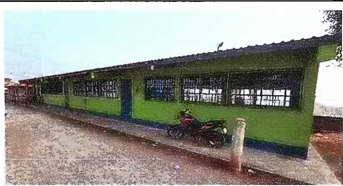
Módulo 1: Suministros e instalación de balcones de hierro en ventana
