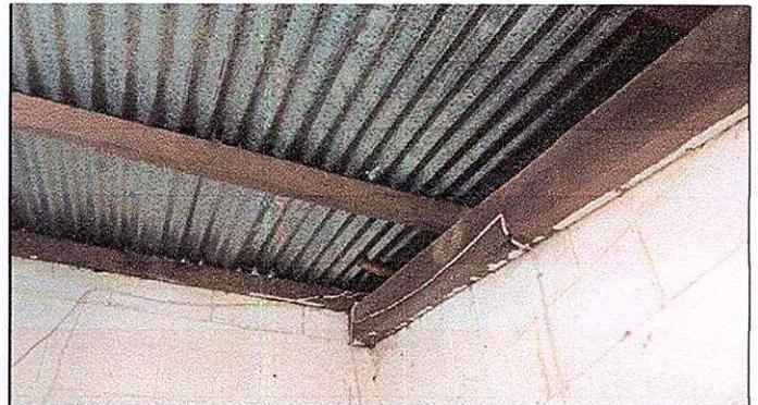
Modulo 1: Sustitución de lámina, por lámina troquelada aluzinc calibre 26, Sustitución de elementos de fijación y sustitución de estructuras de soporte de madera, por metal.
