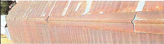
Módulo 1: Sustitución de lámina, por lámina troquelada aluzinc calibre 26 y Sustitución de capote de lámina para lámina troquelada
