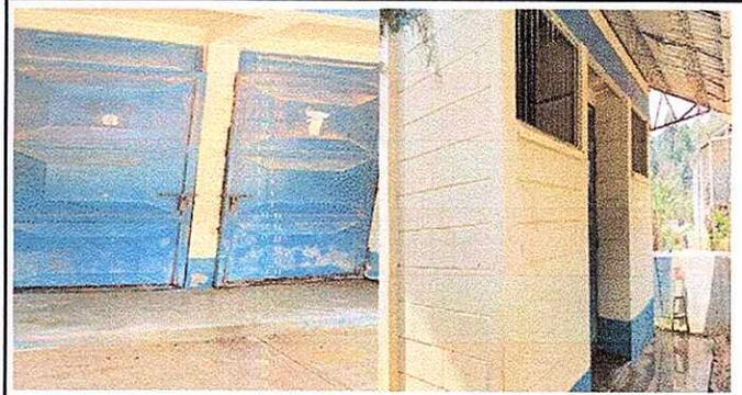
8. Módulo 3: Mantenimiento a estructura (lijado, cambio de tubo , cepillado, sujeciones, aplicación de pintura) y Pintura en muros exteriores e interiores.
