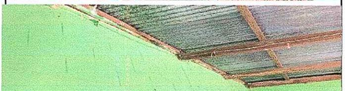
Módulo 1: Sustitución de elementos de fijación y Sustitución de estructura de soporte de madera, por metal
