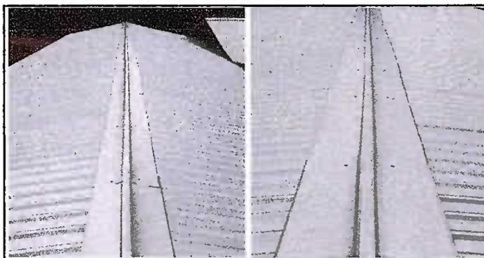
Foto 5: Módulo 2: Sustitución de lámina por lámina troquelada, Sustitución de capote y Sustitución de elementos de fijación (tomillos).
