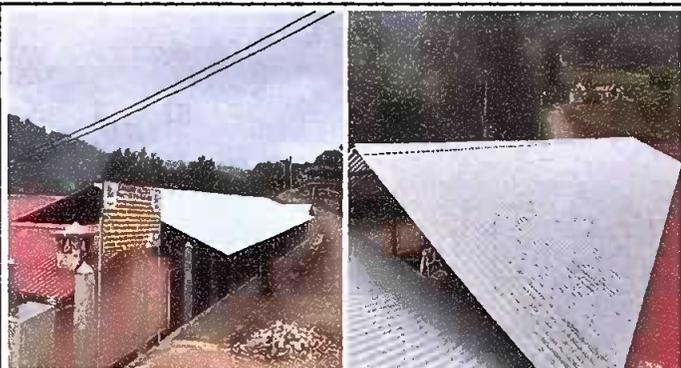
Foto 11: Módulo 4: Sustitución de lámina por lámina troquelada, Sustitución de capote y Sustitución de elementos de fijación (tornillos).
