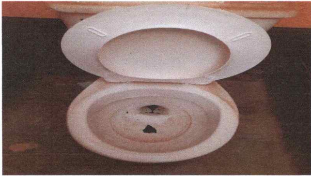
Foto 3: Módulo 1: Sustitución de inodoro.
