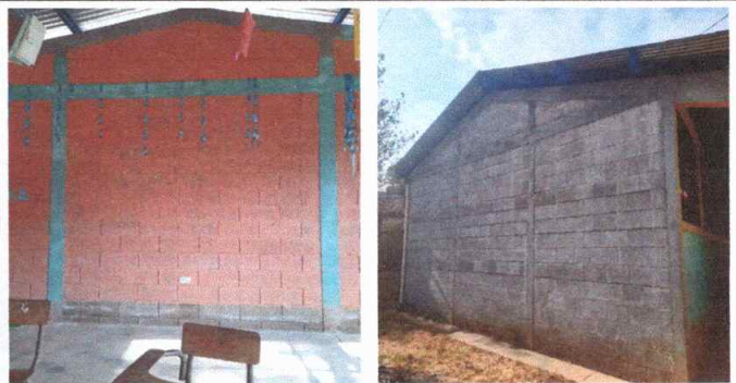
Foto 6: Módulo 2: Pintura de paredes interiores y exteriores.
