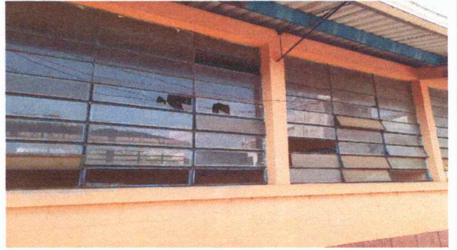
Foto 2: Módulo 1: Sustitución de vidrios.
