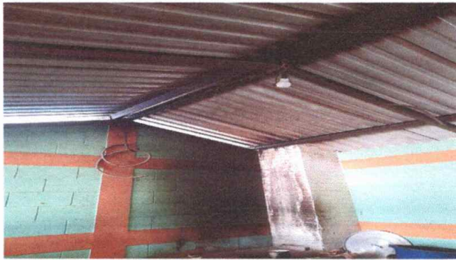
Foto 9: Módulo 3: Sustitución de focos ahorradores y Sustitución de plafoneras.
