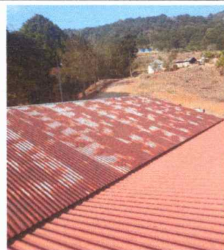
Foto 11: Módulo 4: Sustitución de lámina por lámina troquelada, Sustitución de capote y Sustitución de elementos de fijación (tornillos).
