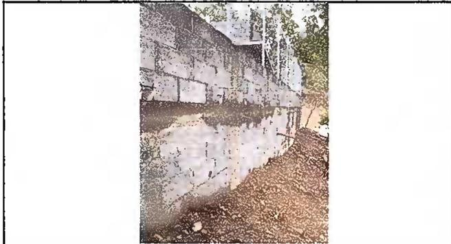
ÁREA EXTERIOR: Reparación de muro perimetral de block con tuvo hg y malla galvanizada, soleras intermedias y columnas.
