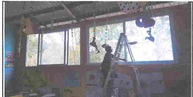
Módulo 3: Sustitución de estructura de metal de ventanas
