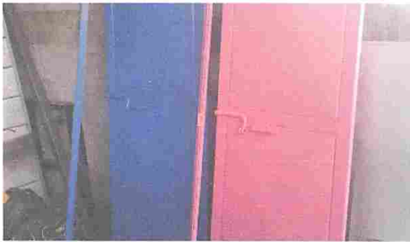
Módulo 2: Sustitución de puertas de metal
