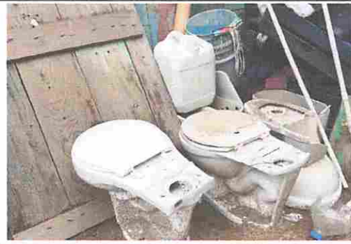
Módulo 2: Sustitución de inodoros
