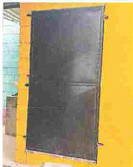
Módulo 2: Mantenimiento a estructura (Lijado, cambio de tubo, cepillado, sujeciones, aplicación de pintura)
