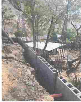
ÁREA EXTERIOR: Reparación de muro perimetral de block con tuvo hg y malla galvanizada, soleras intermedias y columnas.
