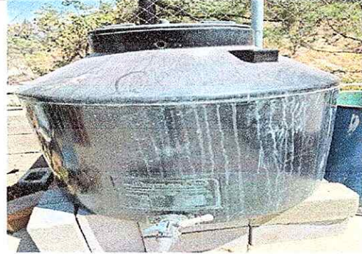
Módulo 2: Sustitución de accesorios de depósito de agua
