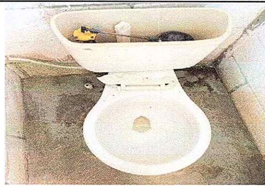
Módulo 2: Sustitución de inodoros
