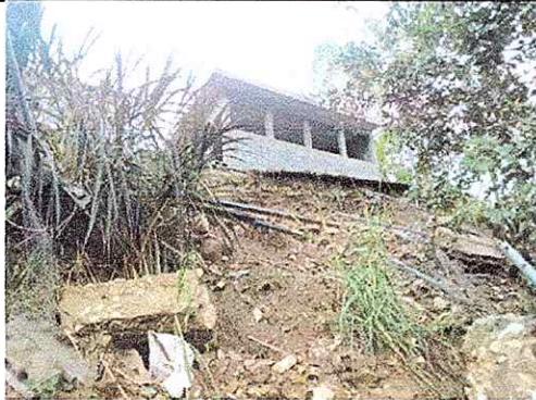
ÁREA EXTERIOR: Reparación de muro perimetral de block con tuvo hg y malla galvanizada, soleras intermedias y columnas.
