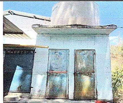
Módulo 2: Pintura a muros exteriores e interiores
