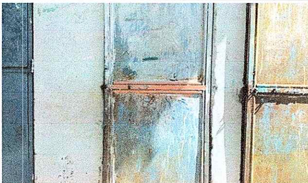
Módulo 2: Sustitución de puertas de metal
