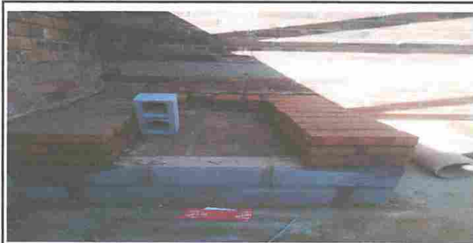
Foto 5: Modulo 1 Reparación de estufa rural durante
