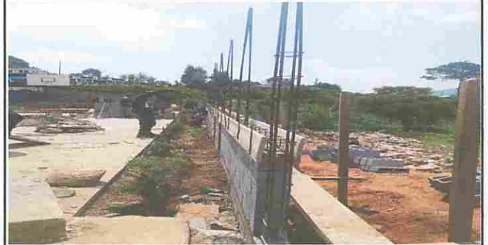
Foto 2: Modulo 2 Reparación de muro perimetral de block durante
