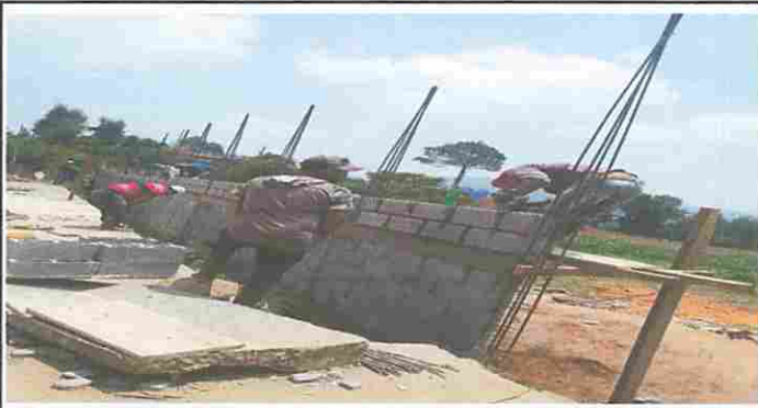
Foto 3: Modulo 2 Reparación de muro perimetral de bck durante
