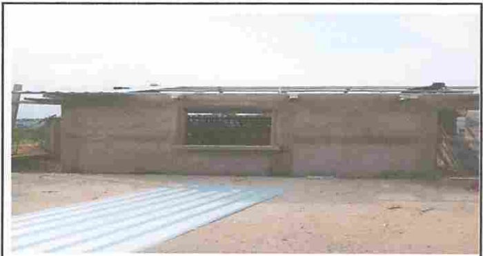
Foto 4: Modulo 1 reparación de cocina durante
