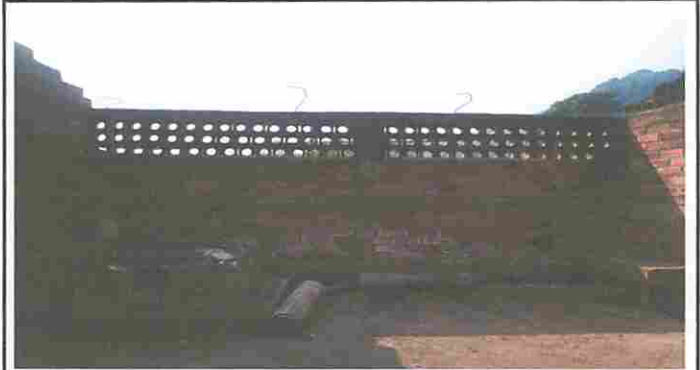
Foto 2: Modulo 1 reparación de cocina durante
