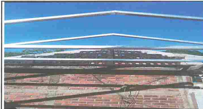
Foto 3: Modulo 1 reparación de cocina durante
