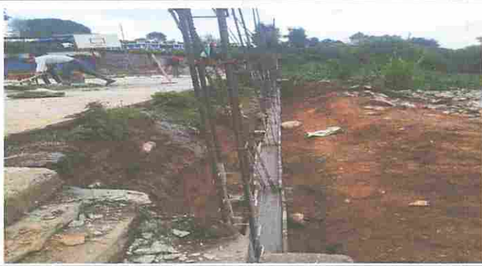
Foto1: Modulo 2 Reparación de muro perimetral de blok durante
