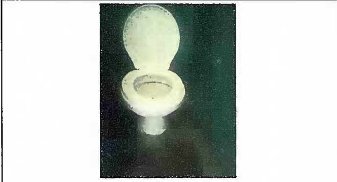
Módulo 4: Sustitución de inodoro
