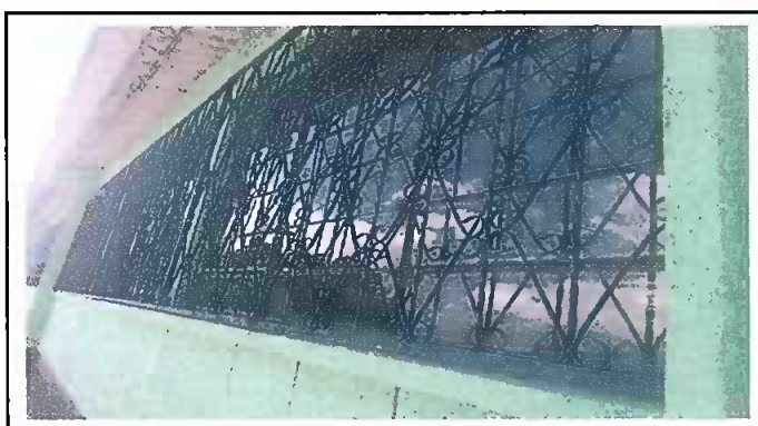
Módulo 3: Sustitución de balcones de metal
