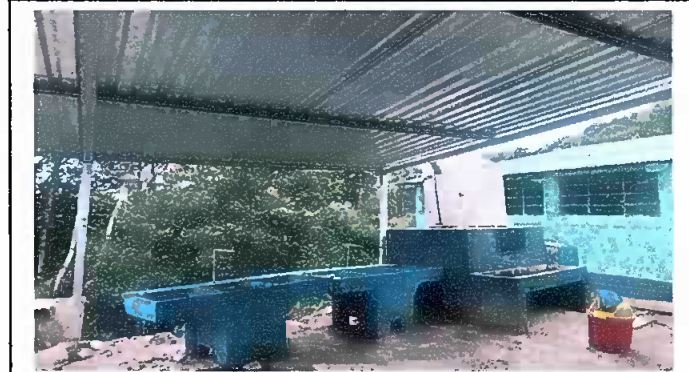
Módulo 5: Sustitución de pila
