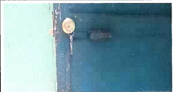
Módulo 2: Sustitución de Chapas
