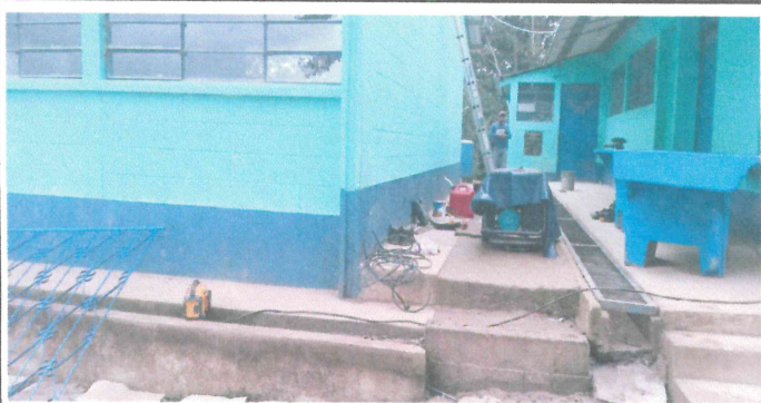
Módulo 3: Sustitución de balcones de metal
