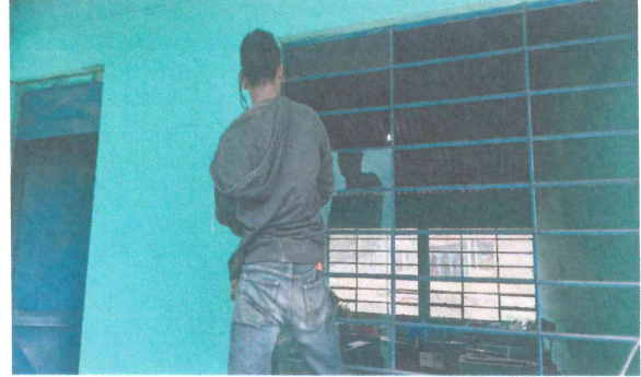
Modulo 1. Sustitucion de vidrios.
