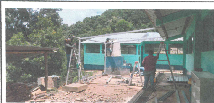
Módulo 5: Sustitución de lámina
