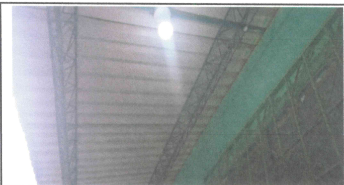
Módulo 3: Sustitución de focos ahorradores
