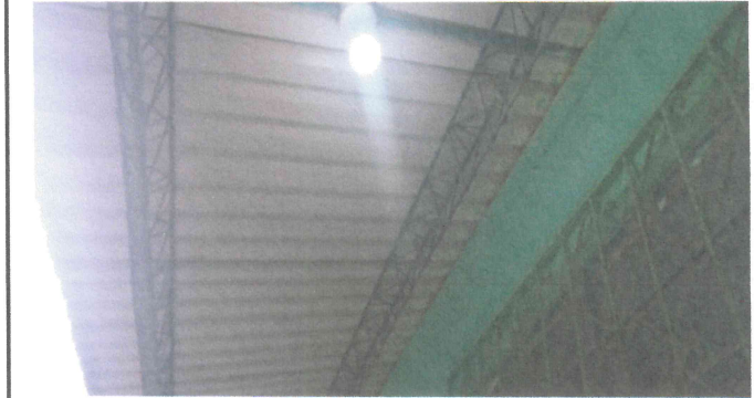
Módulo 4: Sustitución de focos ahorradores
