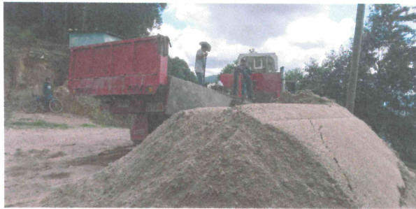
Modulo 2: Reparación de piso de torta de concreto.
