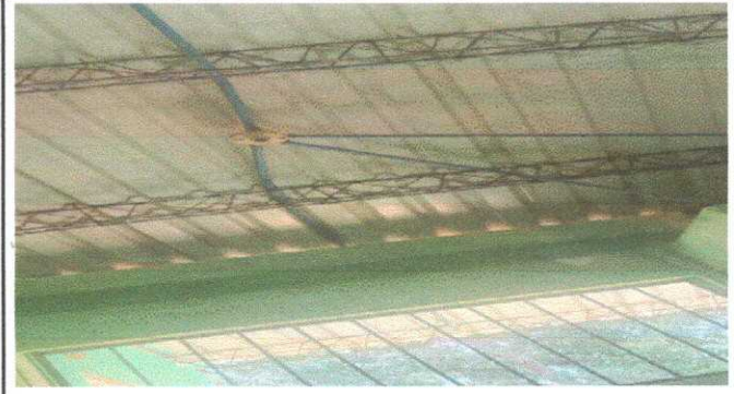
Modulo 4. Sustitucion de focos ahorradores
