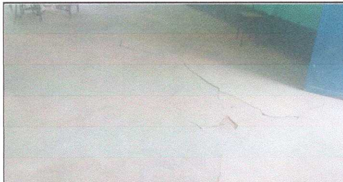
Modulo 2: Reparación de piso de torta de concreto.
