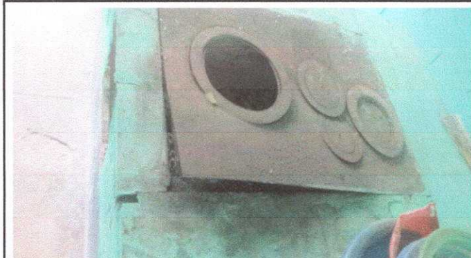
Modulo 1: Sustitución de estufa (completa) incluye chimenea y planca metálica.
