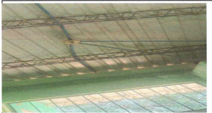
Modulo 1 :sustitucuin de plafoneras
