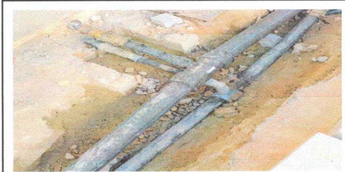
Modulo 5: Sustitución de tubería lineal principal.
