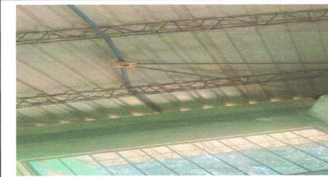
Modulo 4: sustitucion de plafoneras
