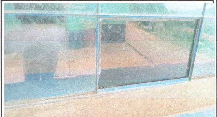
Modulo 1. Sustitucion de vidrios.
