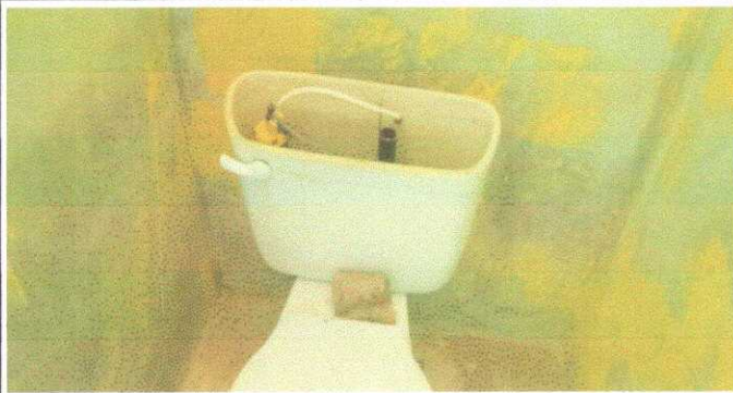
Modulo 4. Sustitucion de inodoro
