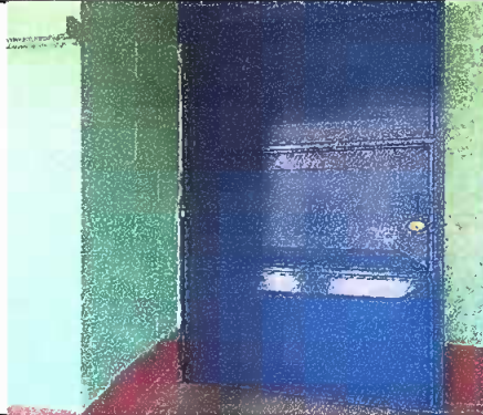
Foto 4: mantenimiento a puertas de metal
