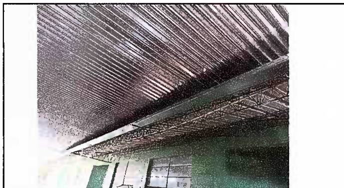
Foto 4: Sustitución de canales de metal
