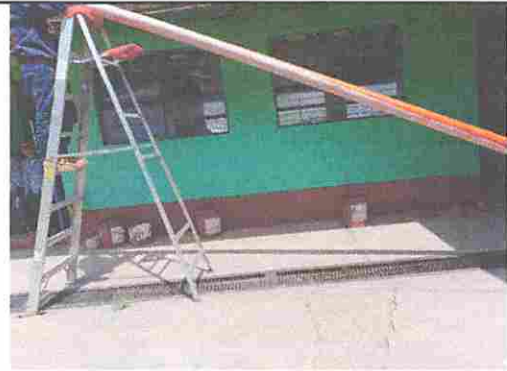
Foto 4: Sustitución de canales PVC a metal
