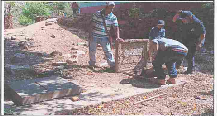
Foto 2: Limpieza de fosa séptica
