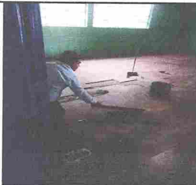
Foto 2: Sustitución de piso cerámico
