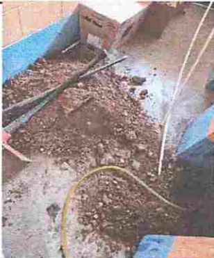
Foto 3: sustitución de tubería de línea principal
