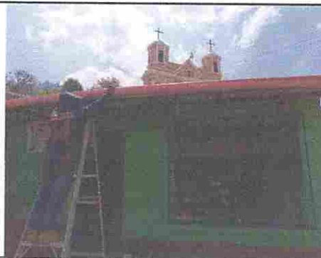
Foto 6: Sustitución de canales de metal
