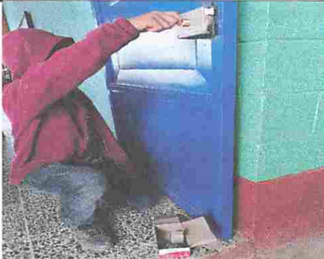
Foto 3: Sustitución de chapas
