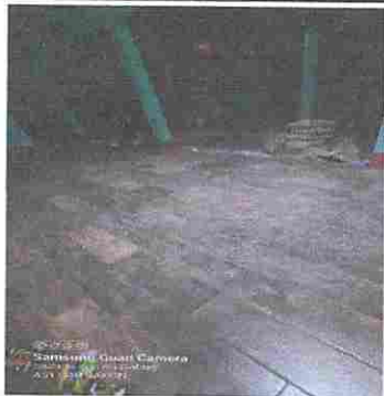
Foto 1: Reparación de piso de torta
