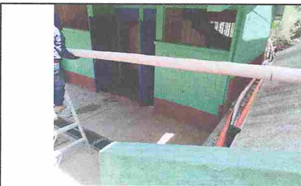
Foto 6: sustitución de canales PVC a metal
