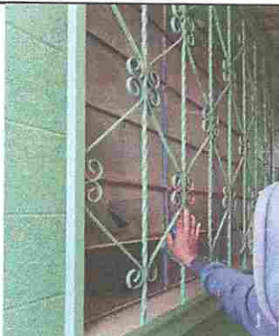
Foto 3: Mantenimiento a balcón de metal
