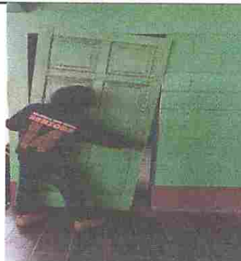
Foto 4: Sustitución de puerta
