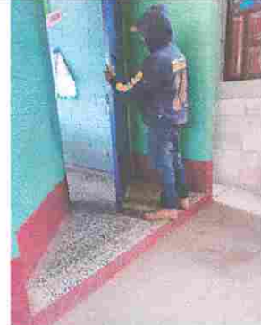
Foto 2: Mantenimiento a estructura de metal de puertas
