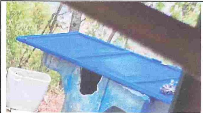
Foto 4: mantenimiento a puertas de metal
