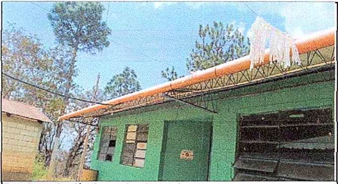
Foto 6: sustitución de canales de metal
