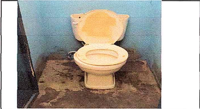
Foto1: Sustitución de inodoro
