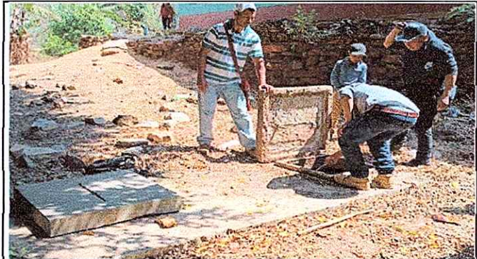
Foto 2: Limpieza de fosa séptica
