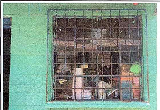
Foto 9: Mantenimiento de estructura de metal de ventana
