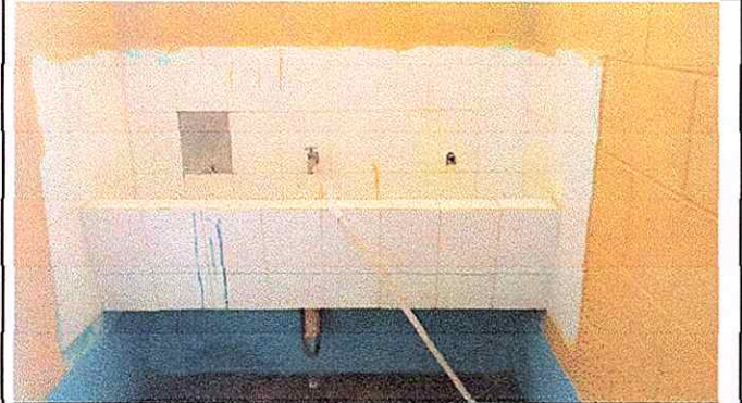
Foto 3: sustitución de tubería de línea principal
