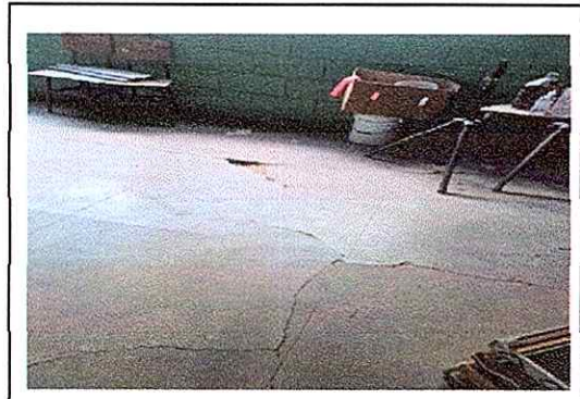
Foto 8: sustitución de piso cerámico
