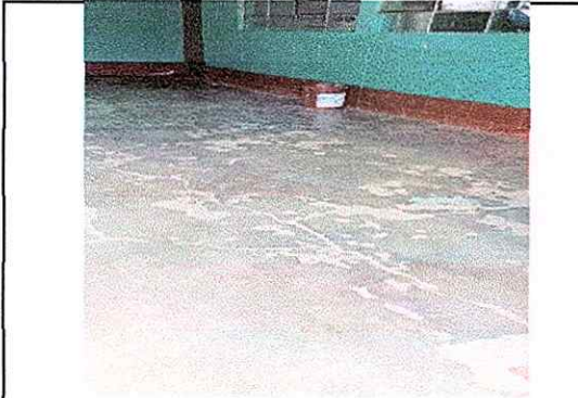
Foto 7: Reparación de piso de torta
