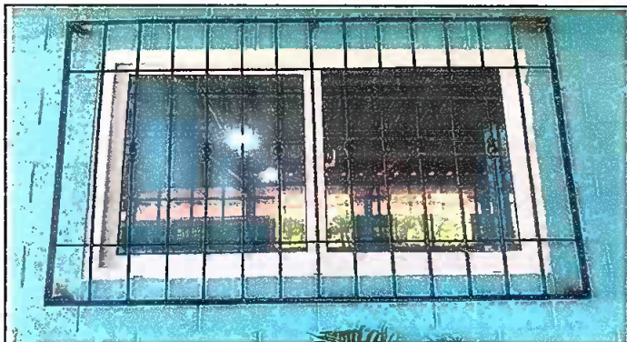
Foto1: finalizado de instalación de balcones de metal en ventanas.
