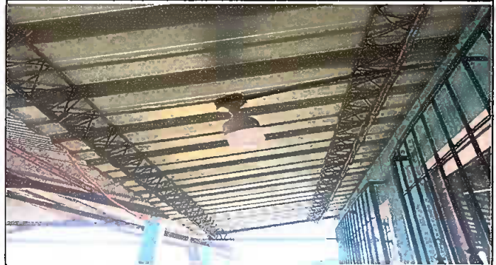
Foto 2: Finalizado de instalació de plafoneras.
