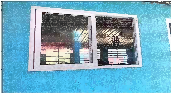
Foto 2: Finalizado instalación de ventanas.
