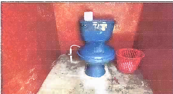
Foto 4: Finalizado de instalación de inodoros.
