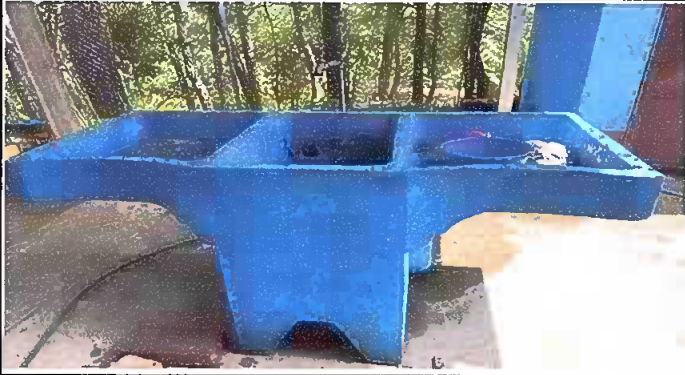
Foto1: Instalacion de pila de cemento de dos lavaderos.
