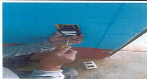
Foto 3: En Proceso Sustitución de Interruptores
