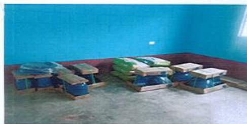
Foto 5: En Proceso Sustitución de inodoro.
