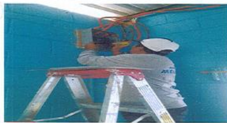
Foto 5: En Proceso Sustitución de Flápones 30 y 50 amperios
