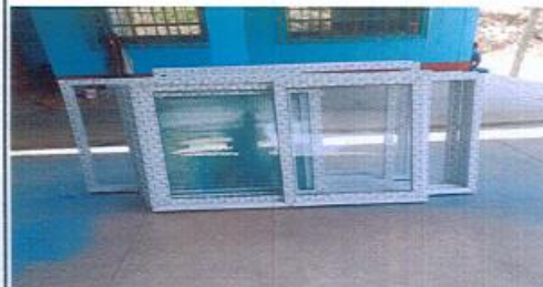
Foto 4: En Proceso Sustitución de ventanas de metal por PVC
