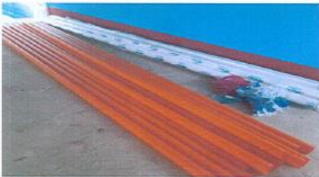
Foto 1: En Proceso Sustitución de canales para agua.
