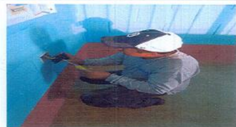
Foto 4: En Proceso Sustitución de Tomacorrientes
