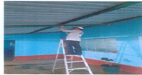
Foto 2: En Proceso Sustitución de Plafones
