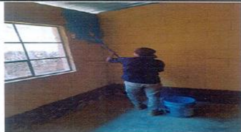
Foto 3: En proceso Pintura en paredes en interiores y exteriores
