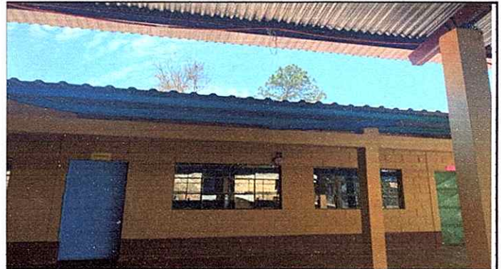
Foto 2: Reparación de bajada de agua plubial, tuvo PVC 3"
