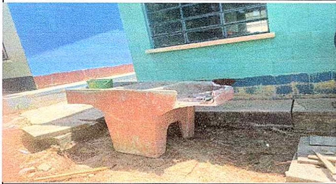
Foto1: Sustitución de pila de cemento de dos lavaderos.
