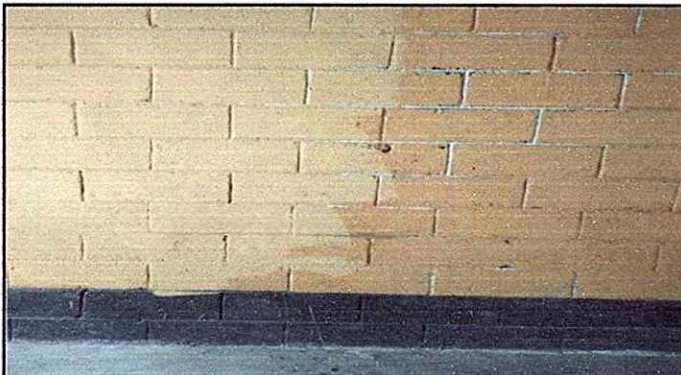
Foto 3: Pintura en paredes en interiores y exteriores
