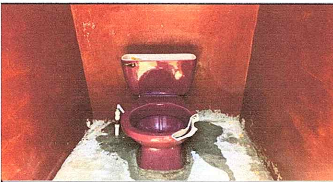
Foto 5: Sustitucion de inodoro.
