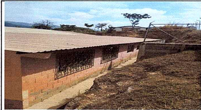
Foto1: Sustitucion de canales para agua.
