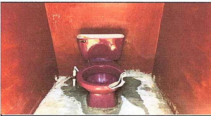
Foto 5: Sustitucion de inodoro.
