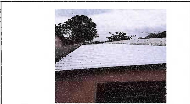
Foto 7: MODULO 4: Sustitución de lámina, por lámina troquelada aluzinc calibre 26, Sustitución de canal de metal, Sustitución de elementos de fijación (tornillo pulser de 2")
