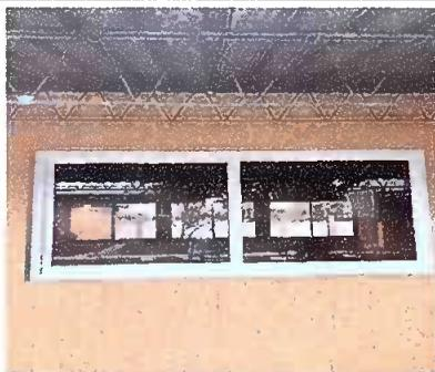
Foto 5: MODULO 3: Sustitución de ventanas de metal por Pvc mas vidrio, Mantenimiento a estructura (aplicación de pintura) puertas de metal
