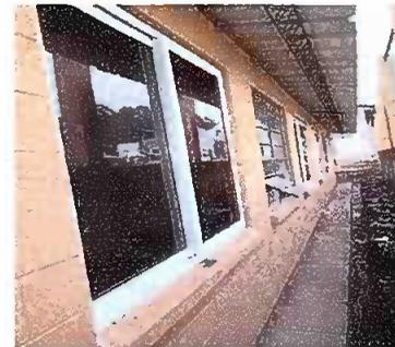
Foto 4: MODULO 2 Sustitución de ventanas de metal por Pvc mas vidrio
