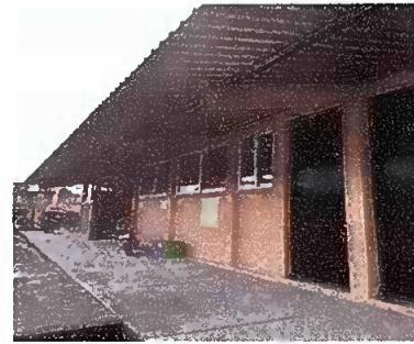
Foto 2: MODULO 1 Sustitución de ventanas de metal por Pvc mas vidrio, Mantenimiento a estructura (aplicación de pintura), Sustitución de chapa
