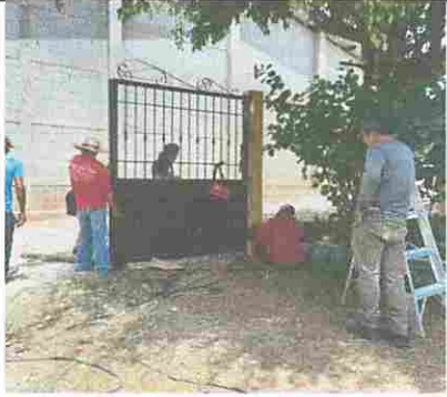
Foto 1: INGRESO: Sustitución de portón de metal y Sustitución de puerta de metal
