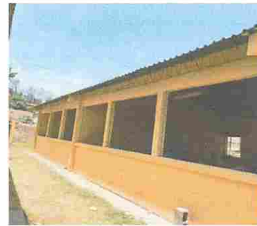
Foto 6: MODULO 3: Sustitución de ventanas de metal por Pvc mas vidrio
