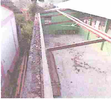
Foto 7: MODULO 4: Sustitución de lámina, por lámina troquelada aluzinc calibre 26, Sustitución de canal de metal, Sustitución de elementos de fijación (tornillo pulser de 2")
