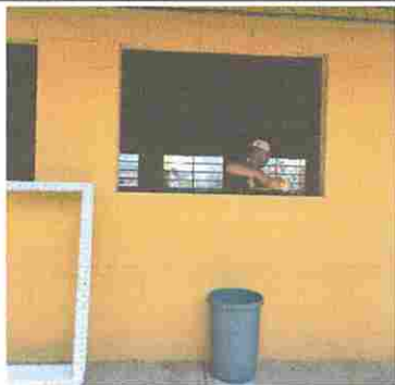
Foto 5: MODULO 3: Sustitución de ventanas de metal por Pvc mas vidrio, Mantenimiento a estructura (aplicación de pintura) puertas de metal
