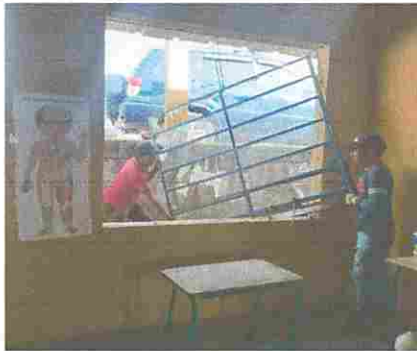
Foto 3: MODULO 2: Sustitución de ventanas de metal por Pvc mas vidrio, Mantenimiento a estructura (aplicación de pintura) puertas de metal
