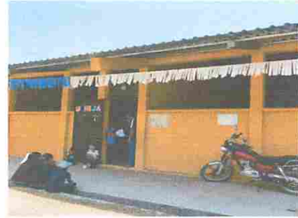
Foto 2: MODULO 1 Sustitución de ventanas de metal por Pvc mas vidrio, Mantenimiento a estructura (aplicación de pintura), Sustitución de chapa
