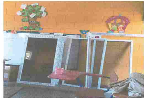
Foto 4: MODULO 2 Sustitución de ventanas de metal por Pvc mas vidrio
