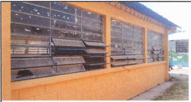
Foto 6: MODULO 3: Sustitución de ventanas de metal por Pvc mas vidrio
