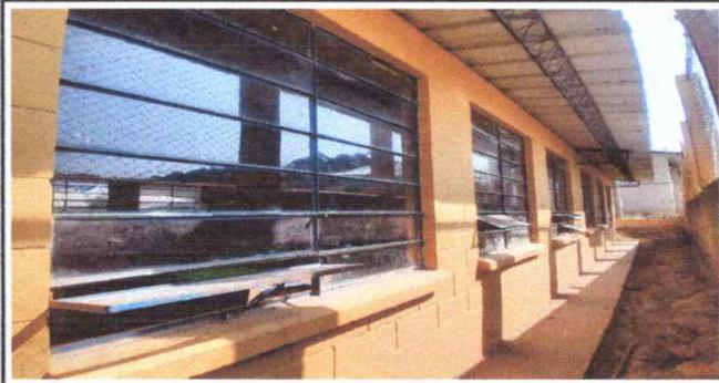
Foto 4: MODULO 2 Sustitución de ventanas de metal por Pvc mas vidrio
