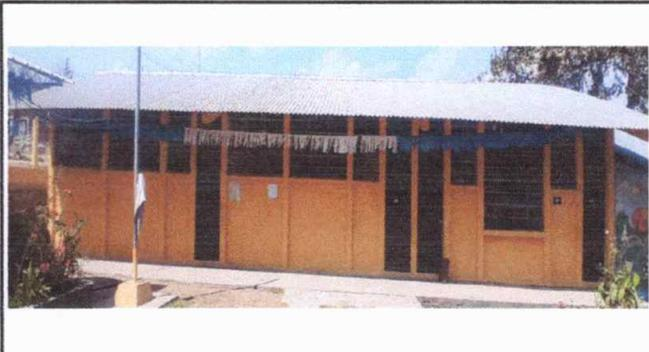
Foto 2: MODULO 1 Sustitución de ventanas de metal por Pvc mas vidrio, Mantenimiento a estructura (aplicación de pintura), Sustitución de chapa
