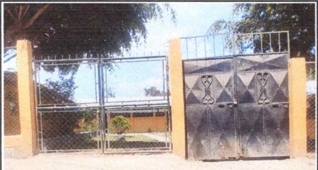
Foto 1: INGRESO: Sustitución de portón de metal y Sustitución de puerta de metal
