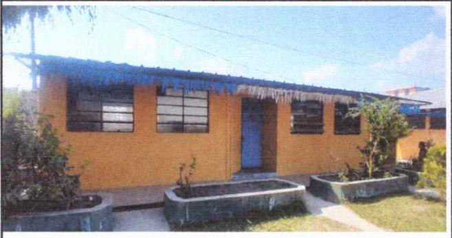
Foto 3: MODULO 2: Sustitución de ventanas de metal por Pvc mas vidrio, Mantenimiento a estructura (aplicación de pintura) puertas de metal
