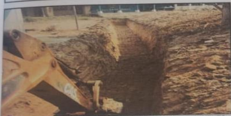
Foto 3: MODULO 2 INSTALACION DE TUBERIA PRINCIPAL DE CEMENTO
