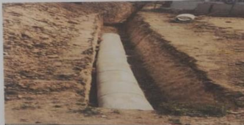
MODULO 2 INSTALACION DE TUBERIA DE PRINCIPAL DEDRENAJE
