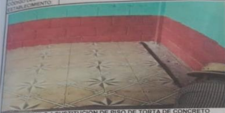
Foto 1: MODULO 1 SUSTITUCION DE PISO DE TORTA DE CONCRETO
