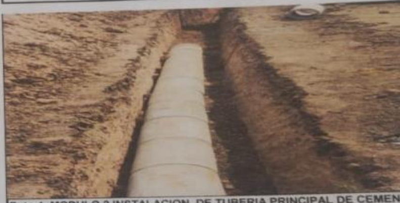
Foto 4: MODULO 2 INSTALACION DE TUBERIA PRINCIPAL DE CEMENTO
