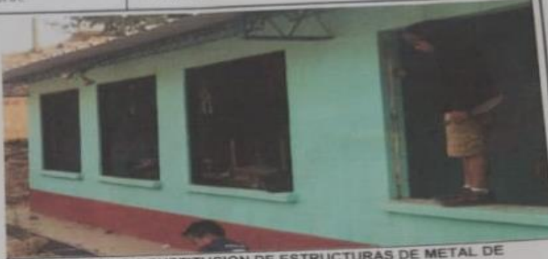
Foto 2: MODULO 1 SUSTITUCION DE ESTRUCTURAS DE METAL DE VENTANAS
