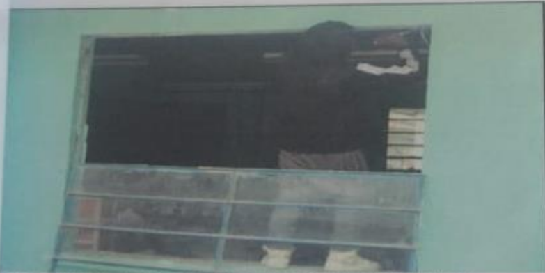
Foto 5: SUSTITUCION DE ESTRUCTURA DE METAL DE VENTANA
