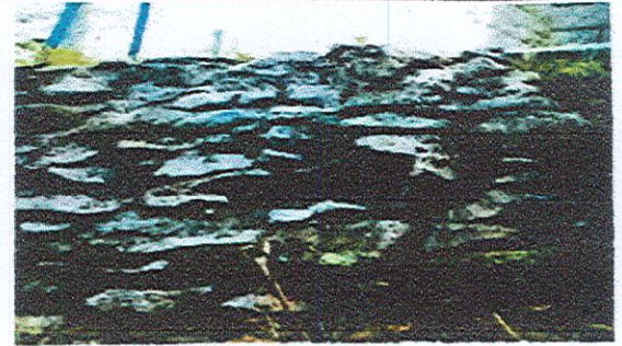
FOTO 2: MURO: Reparación de Muro de Contencion.
