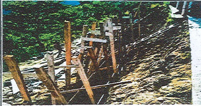
FOTO 2: MURO: Reparación de Muro de Contencion.
