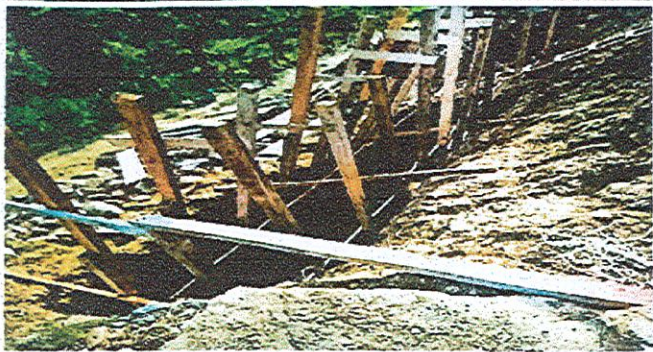
FOTO 1: MODULO 1: Reparacion de Muro de contencion
