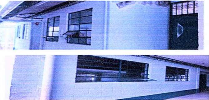
**Modulo 2: Sustitucion de ventanas de vidrio con marco de metal por ventanas corredizas con material de PVC y vidrios**
