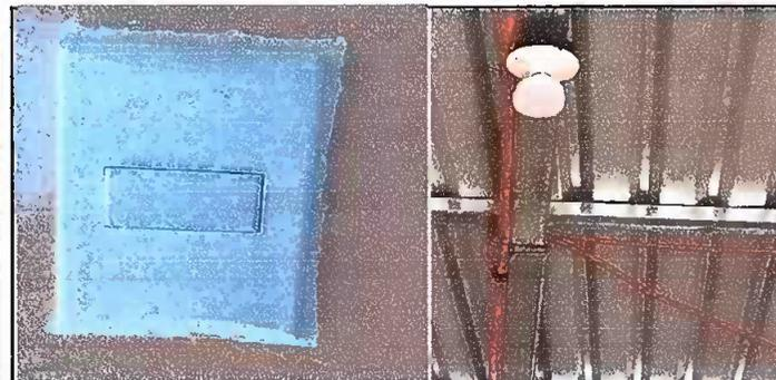
Foto 5: Módulo No. 1 Sustitución de focos ahorradores. Sustitución de plafoneras. Sustitución de interruptores simples. Instalación de tomacorrientes dobles. Instalación de fiplon. Reparación de cableado eléctrico.
