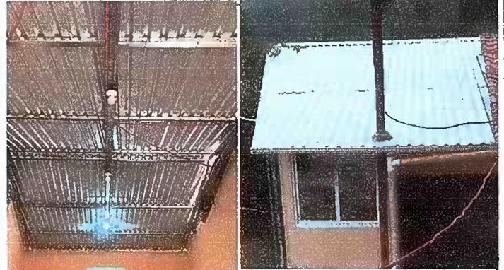
Foto 2: Módulo No. 1 Sustitución de lámina por lámina troquelada. Instalación de capote de lámina, para lámina troquelada. Instalación de elementos de fijación
