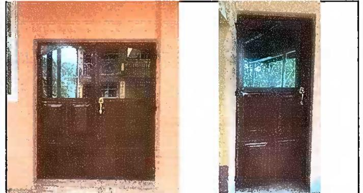
Foto 4: Módulo No. 1 Sustitución de puerta de madera por metal de dos hojas. Sustitución de puerta de madera por metal
