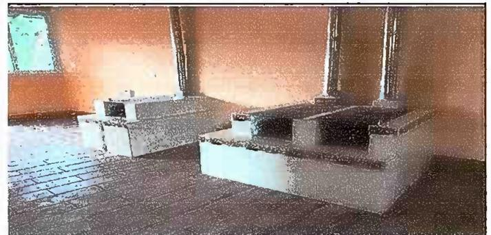
Foto 6: Módulo No. 1 Sustitución de estufas rurales (completa) incluye chimenea y pinchas de metal. Instalación de azulejo en estufas rurales.
