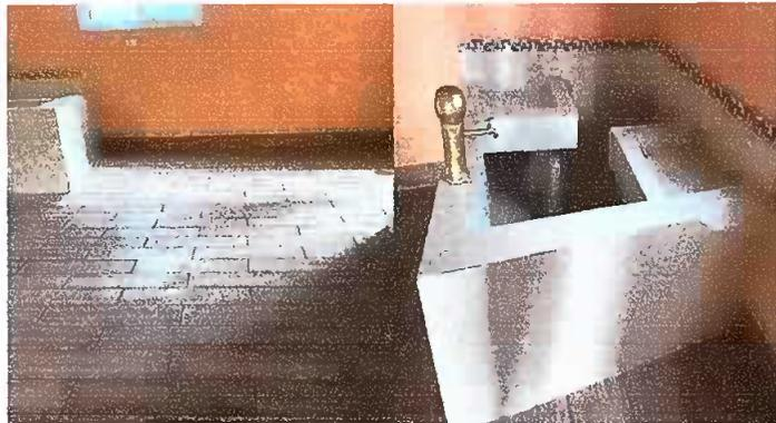
Foto 3: Módulo No. 1 Sustitución de piso de torta de concreto por piso cerámico. Sustitución de pila de cemento de 2 lavaderos.
