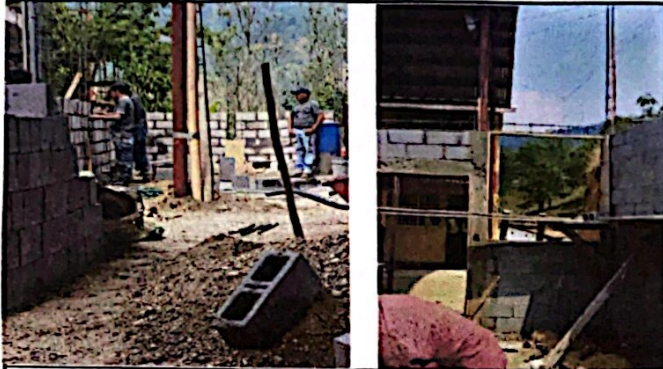
Foto 1: Módulo No. 1 Reparación de pared de block
