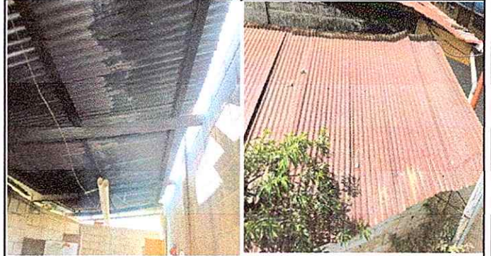
Foto 2: Módulo No. 1 Sustitución de de lámina, por lámina troquelada. Instalación de capote de lámina, para lámila troquelada. Instalación de elementos de fijación
