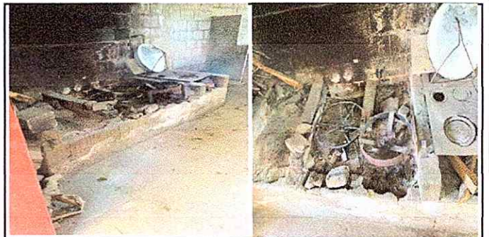
Foto 6: Módulo No. 1 Sustitución de estufas rurales (completa) incluye chimenea y plnchas de metal. Instalación de azulejo en estufas rurales.
