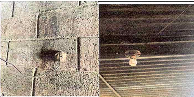
Foto 5: Módulo No. 1 Sustitucion de focos ahorradores. Sustitucion de plafoneras. Sustitución de interruptores simples. Instalación de tomacorrientes dobles. Instalación de fliplon. Reparación de cableado electrico.
