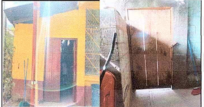
Foto 4: Módulo No. 1 Sustitución de puerta de de madera por metal de dos hojas. Sustitucion de puerta de madera por metal
