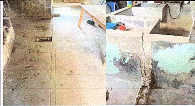
Foto 3: Módulo No. 1 Sustitución de piso de torta de concreto, por piso ceramico. Sustitución de pila de cemento de 2 lavaderos.
