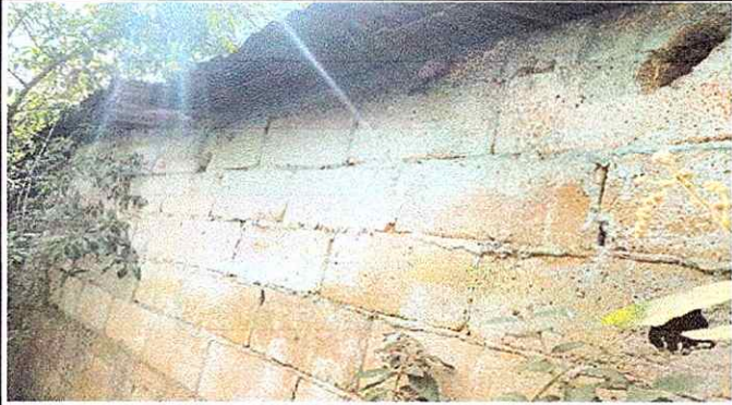
Foto 1: Módulo No. 1 Reparación de pared de block
