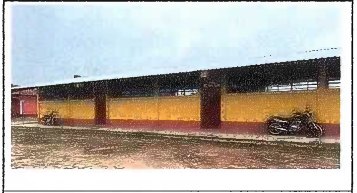
Foto 2: cambio de techado del modulo 1
