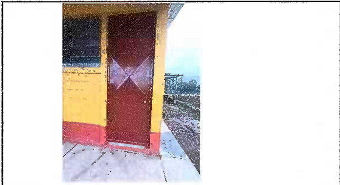
Foto 3: puerta reparado y pintado.
