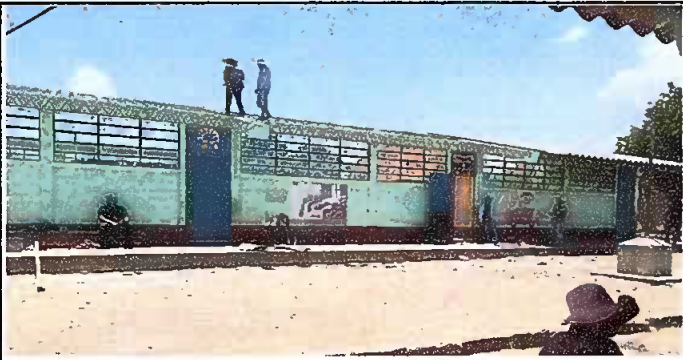
Foto 5: Sustitucion de techado modulo 2 de tres aulas
